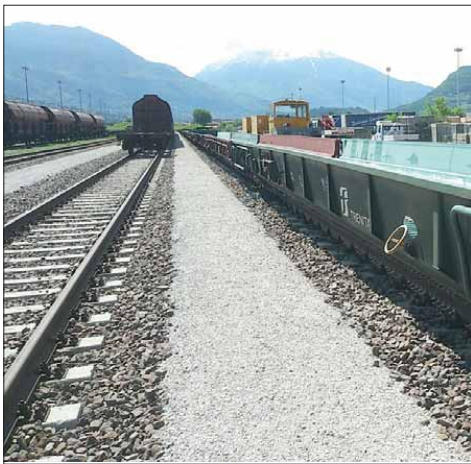
Lo Scalo di Roncafert con i vagoni destinati al trasporto Tir abbandonati
