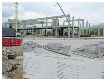
Lavori Cantiere del nuovo deposito di Amazon a Spini (Lossi/Ansa)
