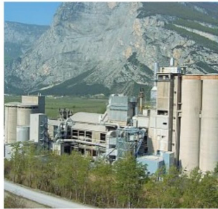
Fabbrica Lo stabilimento Italcementi di Sarche, oggetto di 5 milioni di investimenti
