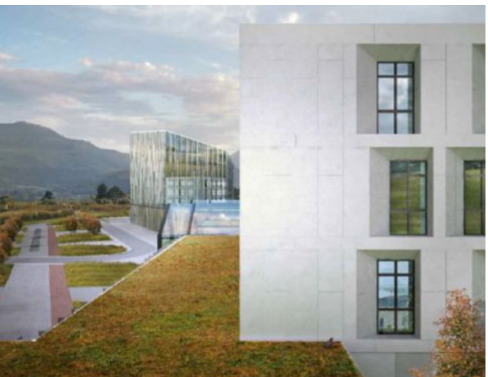
L'appalto La proposta targata Guerrato, che si era aggiudicata la realizzazione del nuovo ospedale di Trento, gara poi azzerata
