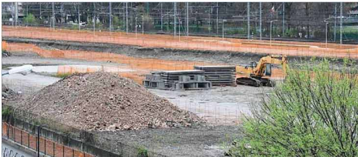
I lavori del cantiere allo scalo Filzi in via Brennero
