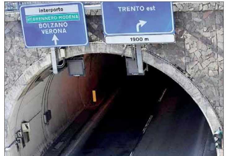
L'entrata della Galleria dei Crozi in direzione Trento dalla Valsugana
